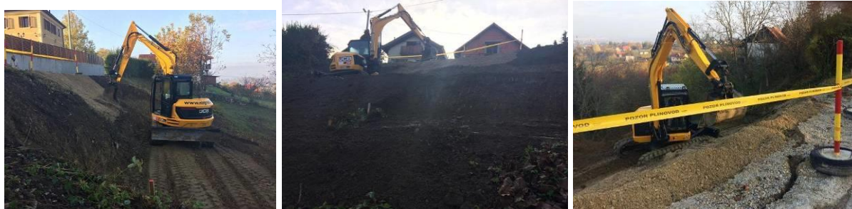
Slike sa sanacije klizišta u Županiji
